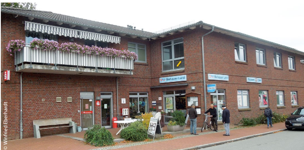
Gebäude eines MarktTreffs
